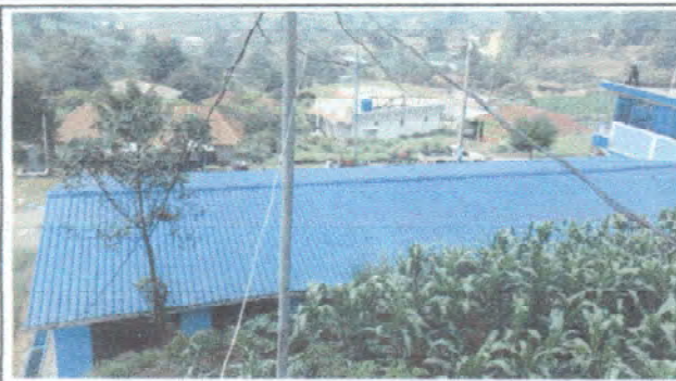
Foto 2: Vista panorámica del techo de la escuela pintada
