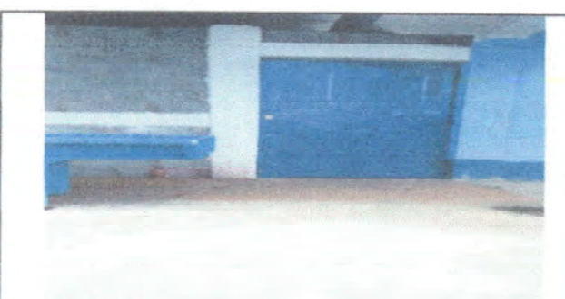
Foto 6: puerta de metal de la cocina arreglada
