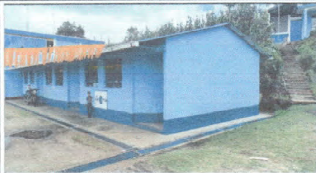
Foto1: Pared exterior remozada
